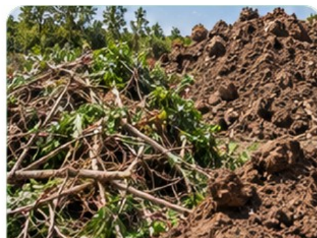
CUBIERTA VEGETAL, MOV. DE SUELOS (200202)
